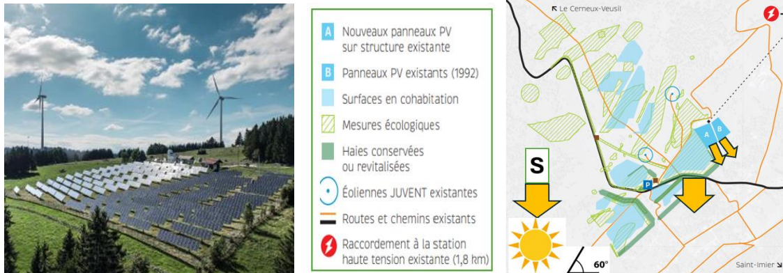
(Sonnenkraftwerk, in Betrieb seit 1992) (PV-Projekt 2024: 60° PV-Flächen blau, ökologische Flächen grün)
