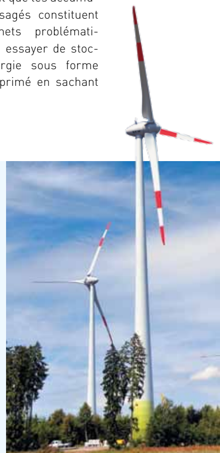
Le parc éolien Landkern intègre le por
