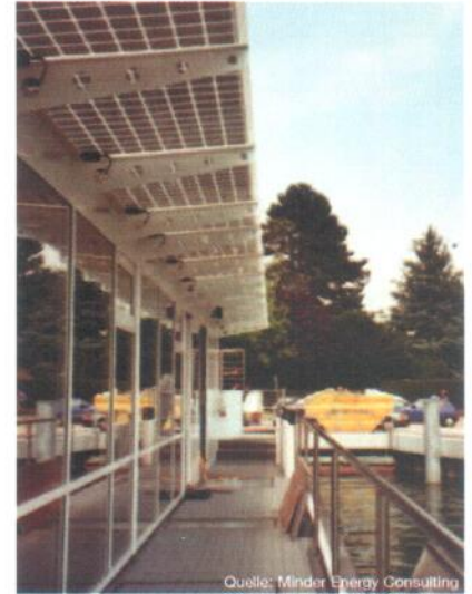
Bild 3 Seitengang mit Ansicht der transluziden Solarmodule
